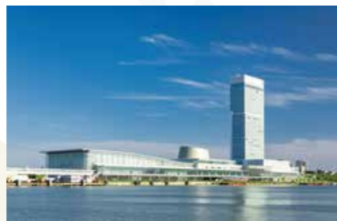
朱鷺メッセ 新潟コンベンションセンター
